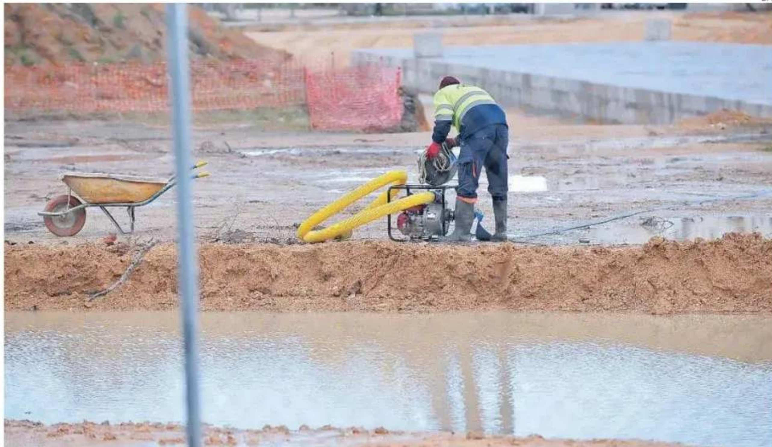
Un operario achica agua en el canal de María Cristina en Albacete
